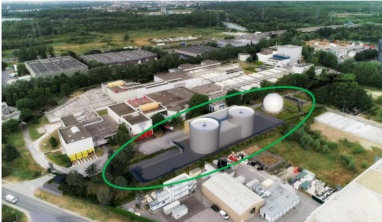
Les deux ouvrages cylindriques correspondent aux deux digesteurs des boues, qui permettront la production de biogaz. La « boule blanche », correspond au gazomètre, équipement permettant de stocker et réguler l'injection de méthane dans le réseau GRDF.
