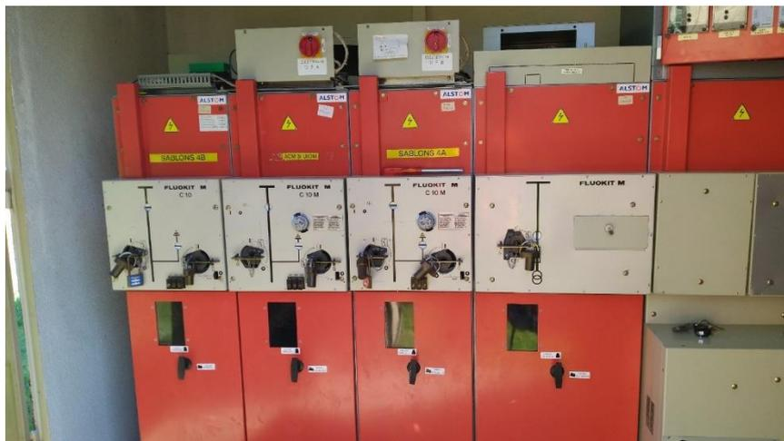
Poste de Livraison EDF - Cellules Haute Tension arrivée EDF (Normal / Secours) et Client
