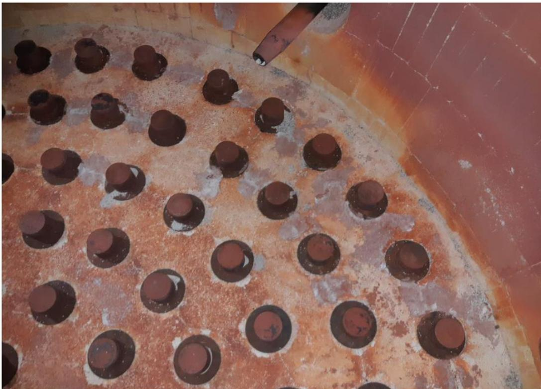
Photos des tuyères après nettoyage, avec canalisation d'alimentation en boues visible
