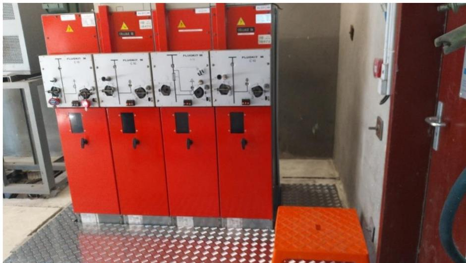
*Cellules Haute-Tension après maintenance. On voit les nouvelles plaques inox installées*
