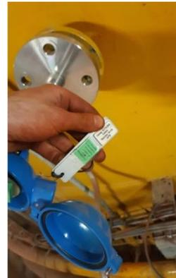
52TE294 -sonde de température lit de sable 3 en cours de renouvellement
