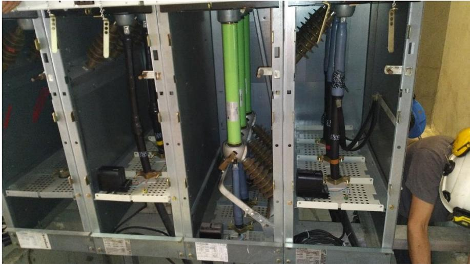
*Cellules Haut-Tension ouvertes et hors-tension, en cours de maintenance*
