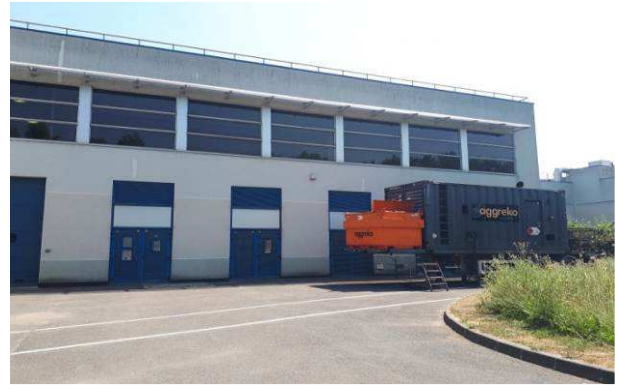
Derrière T4 (décantation)
