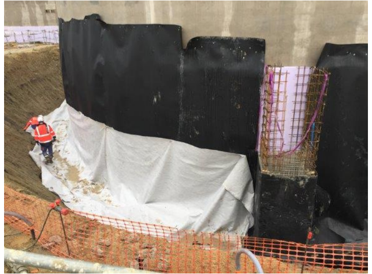
Remontée de la géomembrane (prise en compte de l'arrêté du 16/06/2021)
