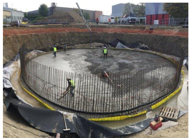
Réalisation du radier du digesteur n°1
