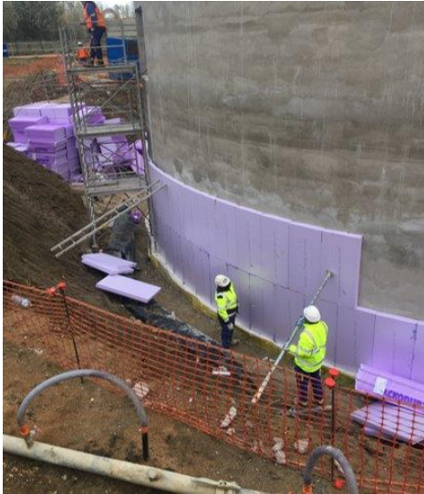
Isolation extérieure pour faciliter le maintien en température optimale du digesteur : 35 à 37°C
