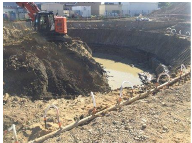
Rabattement de nappe et 2 ème phase de terrassement en débutant par le digesteur n°1
