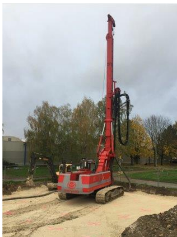
Creusement à la foreuse et coulage des pieux
