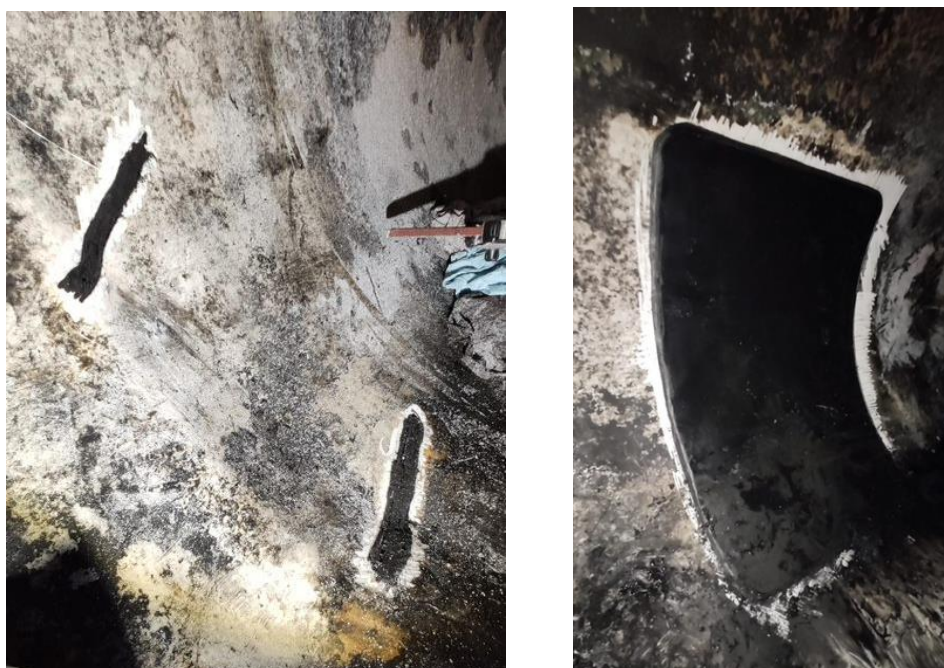
Photos des deux soudures réalisées, ainsi que la plaque fixée en consolidation par-dessus
