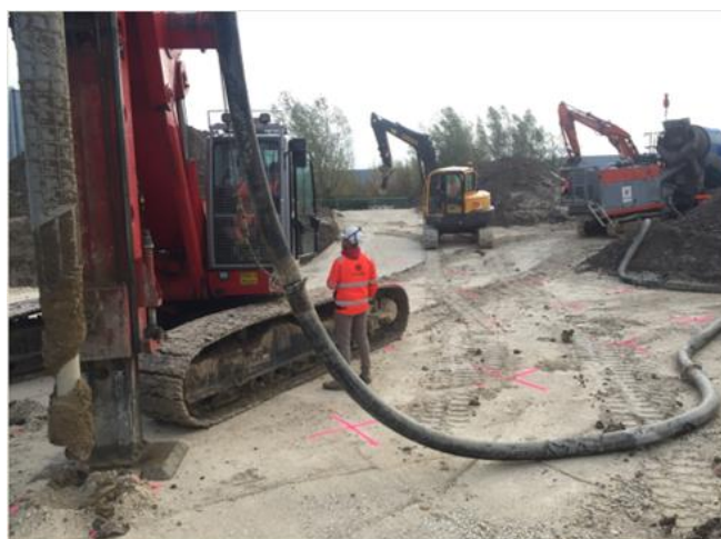
Creusement à la foreuse et coulage des pieux
