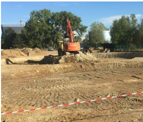
1 ère phase de terrassement
