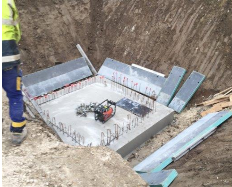
Démarrage de la construction des ouvrages annexe Illustration de la torchère
