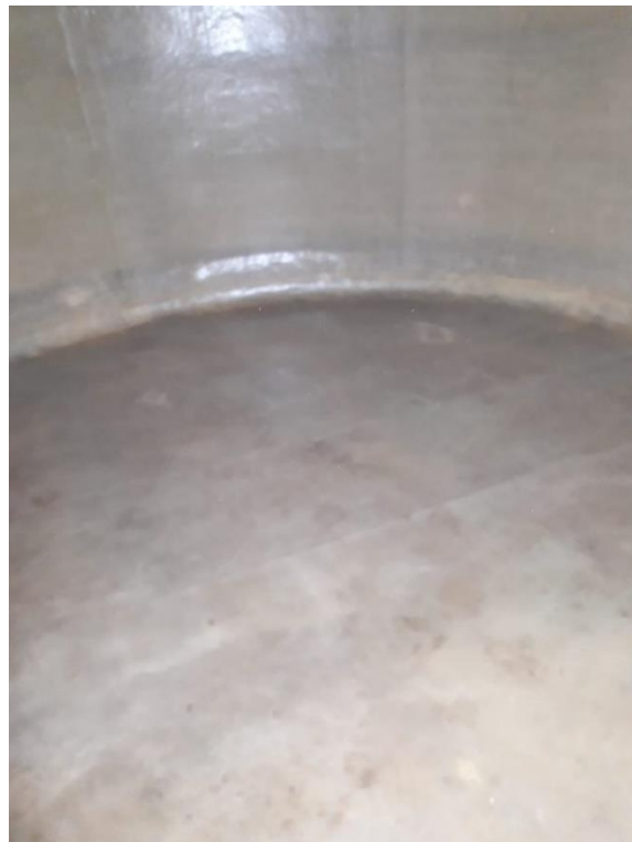
Fond de la cuve après reprise de l'étanchéité
