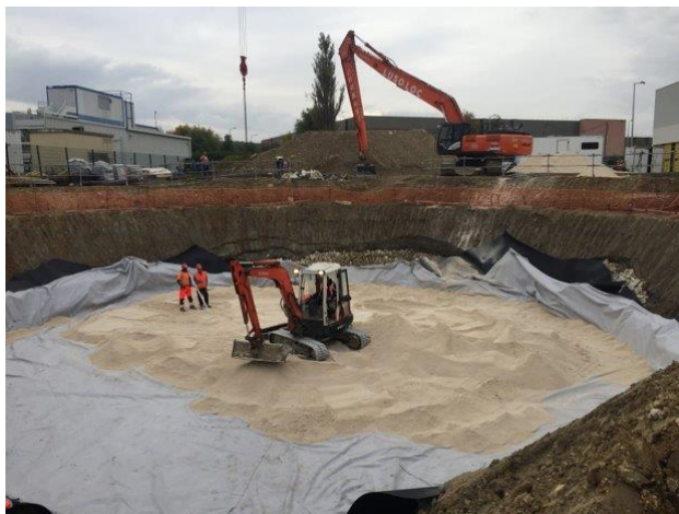
Pose de la géomembrane
