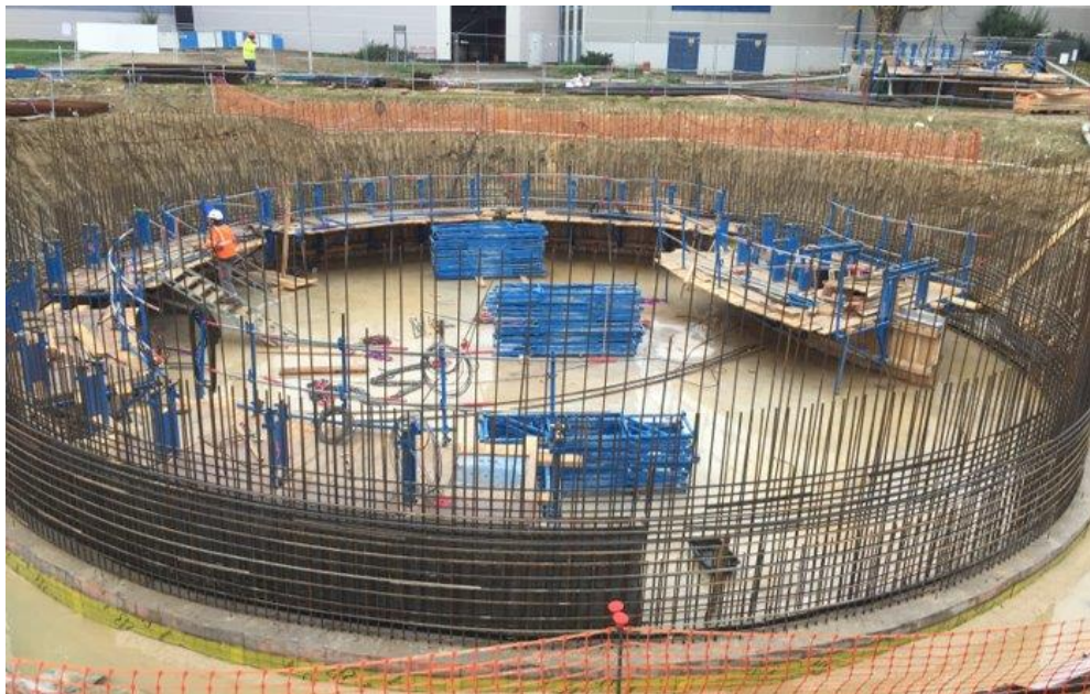
Digesteur n°2 : Poursuite de la réalisation du génie-civil
