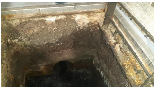
Béton dégradé
